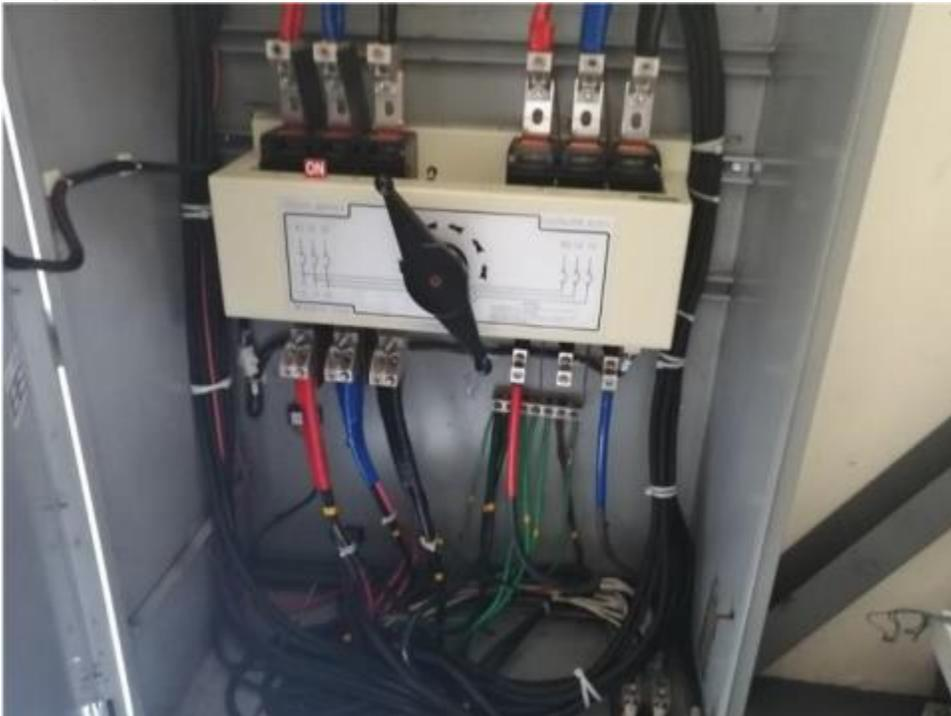
Los Interruptores deben ser colocados en el cuarto eléctrico a la par de la transferencia o se toman como referencia para utilizarlos como principal del tablero correspondiente, si se debe colocar y de ahí sacar la acometida para cada tablero principal, indicar que tipo de gabinete debe utilizar si NEMA 1 o NEMA 3R.
