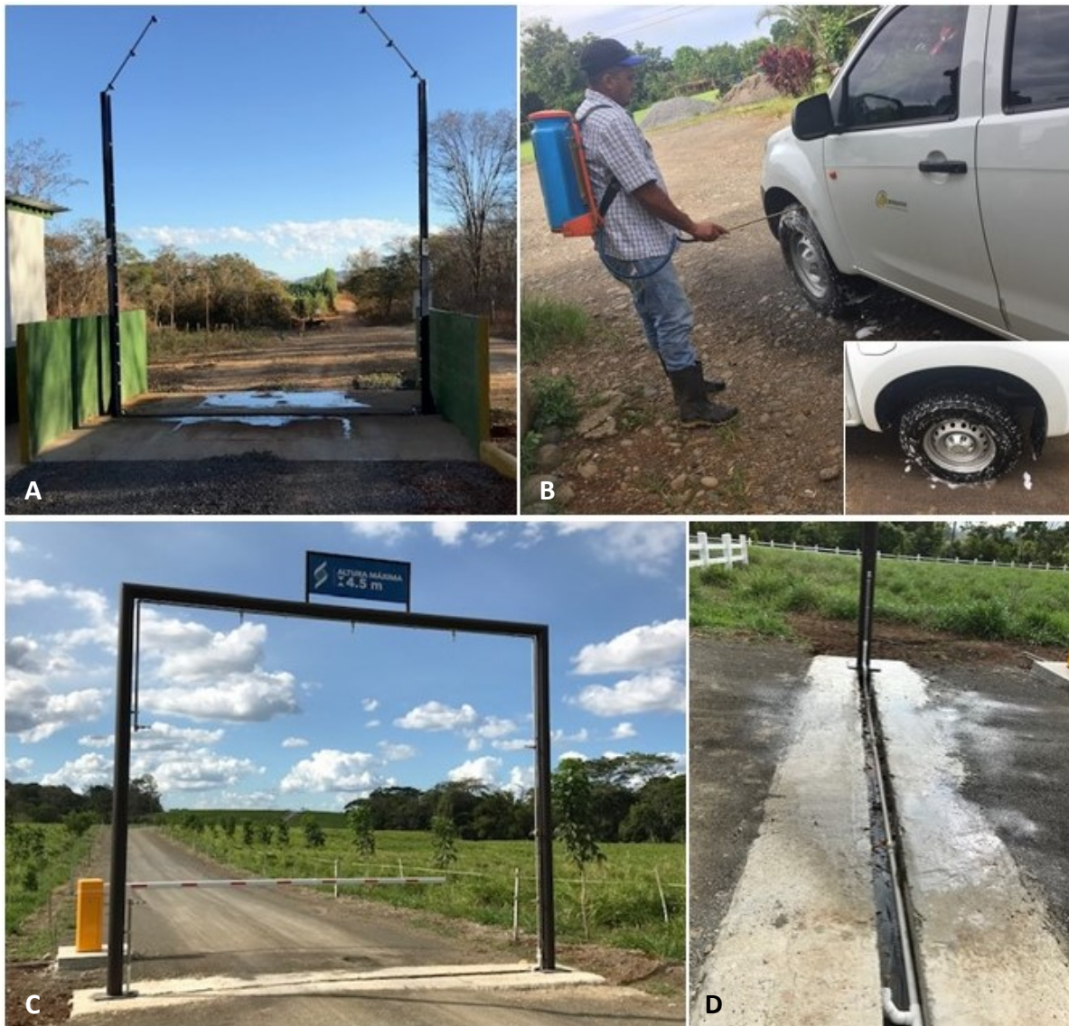
Figura 14. Ejemplos de facilidades para desinfección de vehículos, camiones y maquinaria. A. Arco de desinfección en finca bananera en Brasil. B. Desinfección mediante el uso de bomba manual de espalda en una finca bananera de Costa Rica, nótese el correcto humedecimiento del rodaje del vehículo. C. Arco de desinfección en una finca de Costa Rica, nótese la aguja para el control de ingreso. D. Dispositivo para fumigación de la parte inferior del vehículo del arco mostrado en C. Fotos: M. Guzmán, CORBANA.
