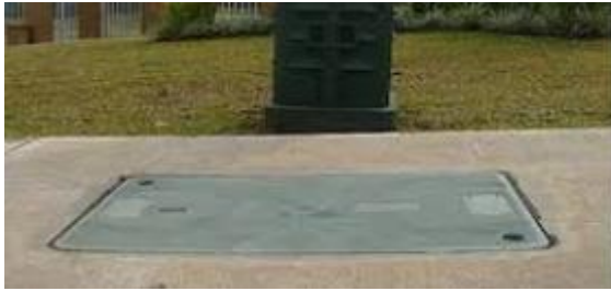
Caja de registro en acera.
