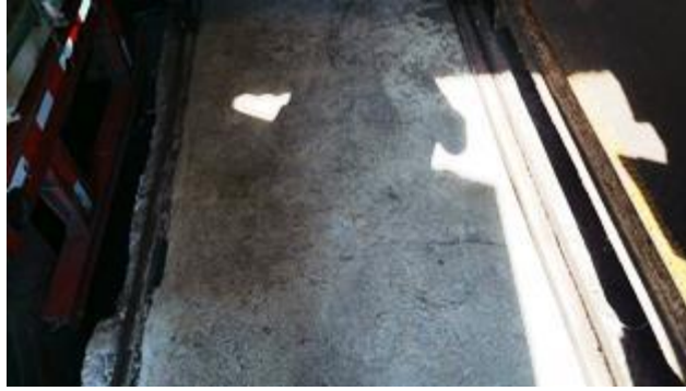
Losa con guías para niveladores
