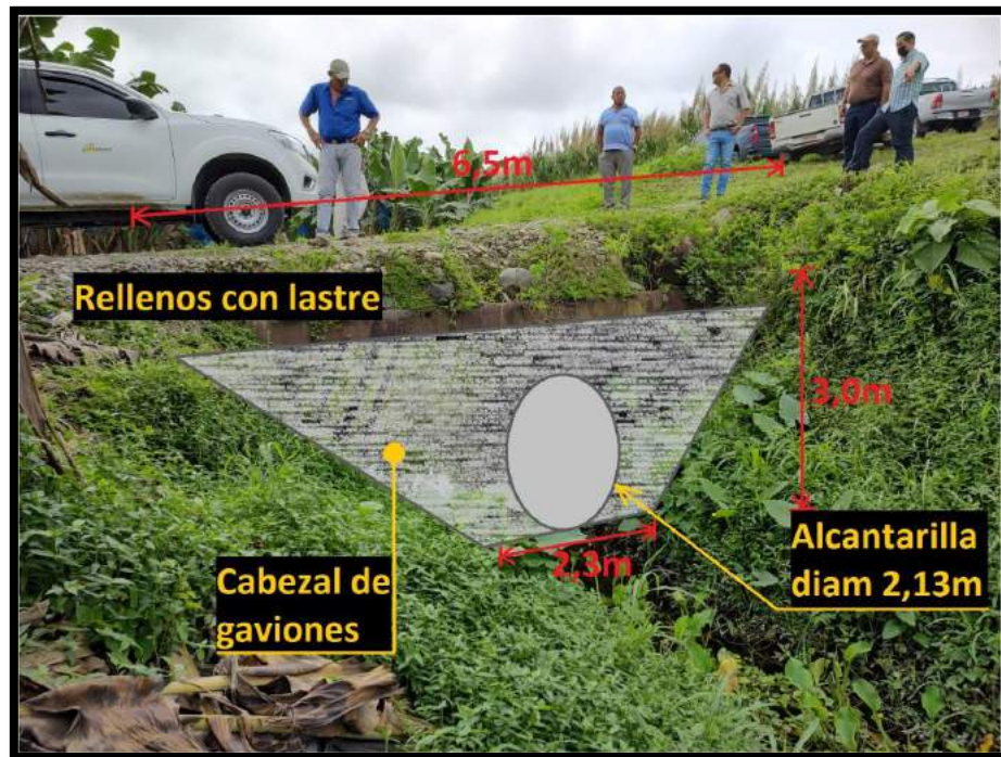
Figura 6. Vista en elevación de obra para paso sobre canal en acceso a sitios de proyecto. Fuente: FEPI-CORBANA, 2022
