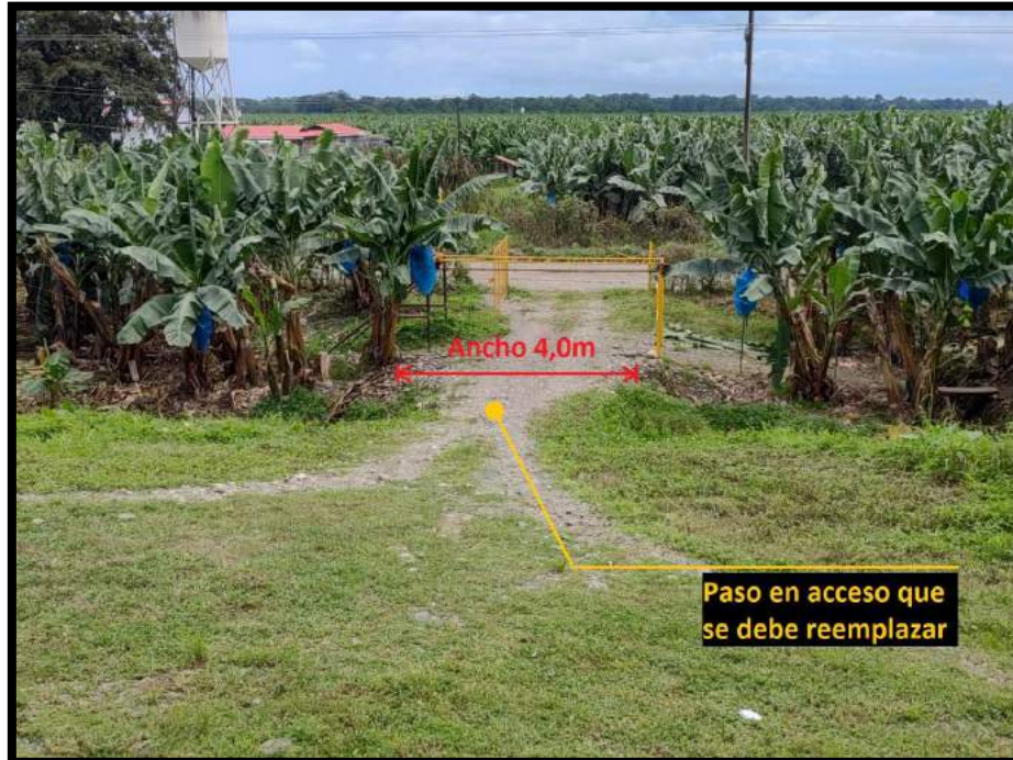
Figura 7. Vista superior de obra para paso sobre canal en acceso a sitios de proyecto. Fuente: FEPI-CORBANA, 2022
